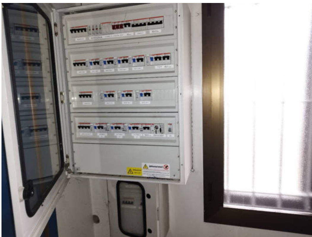
Particolare comandi impianto di riscaldamento/raffrescamento
