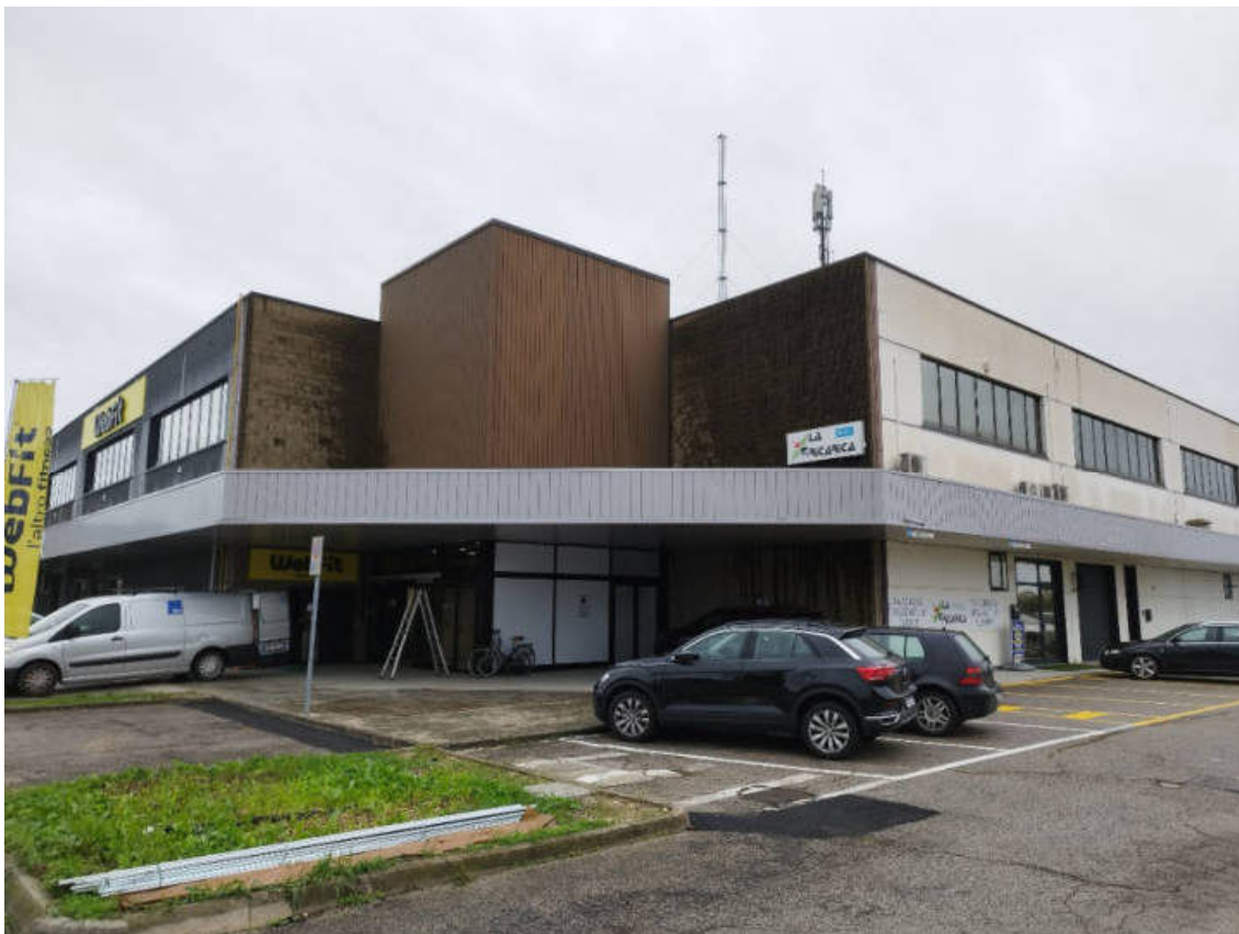
Particolare vista prospettica fronte strada
