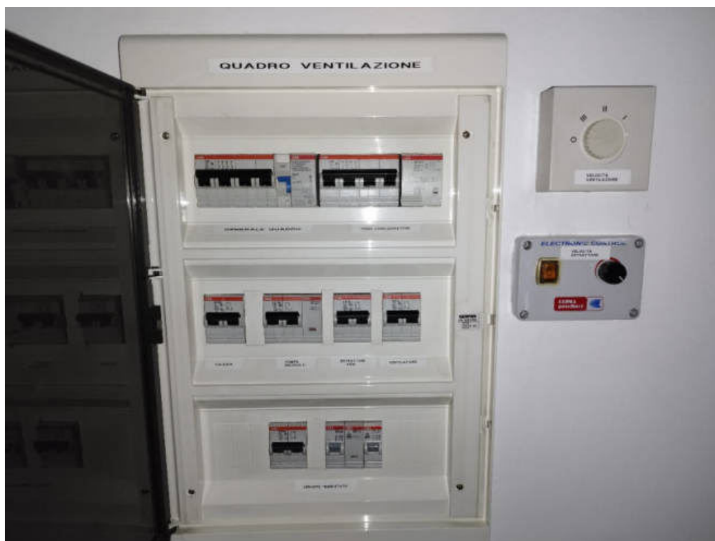
Particolare comandi impianto di riscaldamento/raffrescamento
